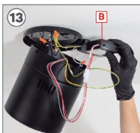
13 Una vez conectados los cables, introduzca la pieza B dentro de la pieza F, como se muestra en la imagen.
