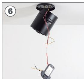
Une las conexiones de la pieza **F** con las de la pieza **B**, cada una con su color correspondiente.
