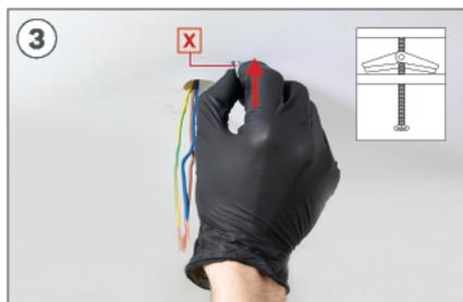
3 Introduzca los tornillos de fijación en los agujeros y asegúrese de que la palanca se abre.
