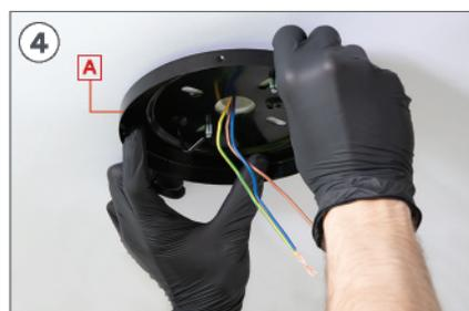
4 Coloque la pieza A haciendo coincidir sus agujeros con los tornillos D. Asegúrese de que los cables del techo pasan por el agujero central de la pieza A.
