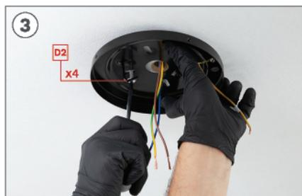
3 Coloque la arandela y posteriormente el tornillo D2 con la ayuda del destornillador.
