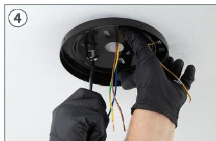
4 Coloque la pieza A y atornille los tornillos de fijación al falso techo.
