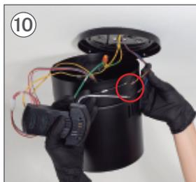
10 Conecte el cable NEUTRO del driver (AC-N) al cable NEUTRO de su instalación.
