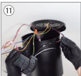
11 Conecte el cable FASE del driver (AC-N) al cable NEUTRO de su instalación.
