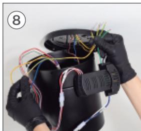
8 Seleccione y conecte todos los cables de toma tierra, incluyendo el de su instalación.
