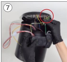
7 Seleccione y conecte todos los cables de toma tierra, incluyendo el de su instalación.
