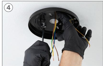
Coloque la pieza A y atornille los tornillos de fijación al falso techo.
