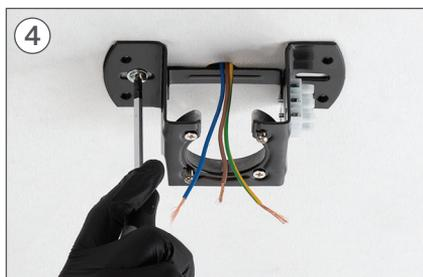
Coloque la pieza K y atornille los tornillos de fijación al falso techo.
