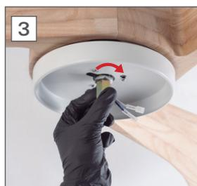
Introduzca con cuidado los cables del ventilador por el interior de la pieza S y sáquelos por el agujero grande lateral de la pieza. Después, enrosque la pieza S y compruebe que queda bien sujeta al ventilador.
