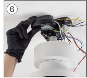
Una vez conectados los cables, introduzca la pieza **K** dentro de la pieza **B**, como se muestra en la imagen.
