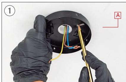
1 Marque en el techo con un lápiz 2 orificios paralelos utilizando la pieza A como guía.
