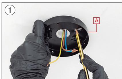
1 Marque con un lápiz 2 orificios paralelos utilizando la pieza A como guía.
