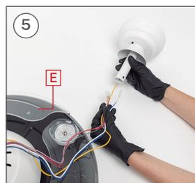
Una vez introducidas las piezas A y K, deberá introducir los cables de la pieza E por dentro de la tija. Si lo desea, puede sujetar los cables con cinta aislante para que sea más fácil pasarlos por dentro.
