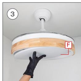
Coloque la pieza F doblándola ligeramente para encajarla en el cuerpo del ventilador. Una vez haya comprobado que la pieza queda bien sujeta, podrá conectar la electricidad y disfrutar de su nuevo ventilador con luz.
