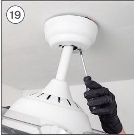
19 Finalmente, con la ayuda de un destornillador, apriete los tornillos del lado derecho.
