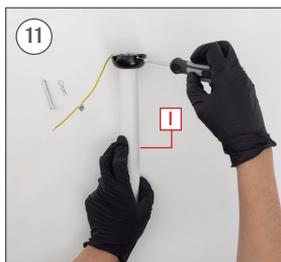
Apriete los dos tornillos del soporte de inclinación con el destornillador.
