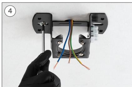
Coloque la pieza J y atornille los tornillos de fijación al falso techo.
