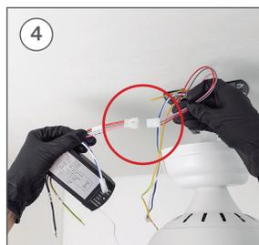
Una las conexiones de la pieza B con las conexiones del motor, cada una con su color correspondiente.
