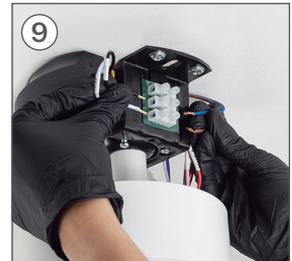
Sie müssen die verbleibenden Drähte im Teil bündeln **B** und die Phase- und Neutralleiter seiner Installation im Klemmenblock des Stückes **K**, wie es im Folgenden gezeigt wird.
