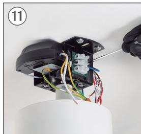
Verbinden Sie das N-Kabel des Treibers mit dem NEUTRAL-Kabel Ihrer Installation.
