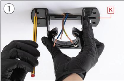
1 Markieren Sie mit einem Bleistift die 4 Löcher des Stücks an der Decke K.
