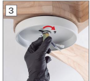
Führen Sie die Lüfterkabel vorsichtig in das Teil ein S und nehmen Sie sie heraus durch das große seitliche Loch des Stückes. Dann schrauben Sie das Teil S und überprüfe das Überreste sicher am Lüfter befestigt.
