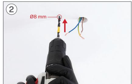
2 Bohren Sie mit Hilfe eines Bohrers die beiden entsprechenden Löcher mit einem Bohrer mit  $\text{Ø}8 \text{ mm}$ .
