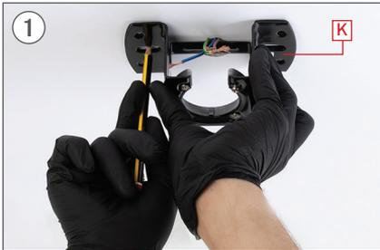
1 Markieren Sie an der Decke mit einem Bleistift die 2 zentralen Löcher des Stücks Kunter Verwendung des gleichen Stücks als Leitfaden.
