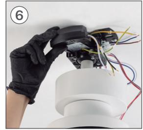
Sobald die Kabel angeschlossen sind, stecken Sie das Teil ein **B** innerhalb des Stückes **K**, wie im Bild gezeigt.
