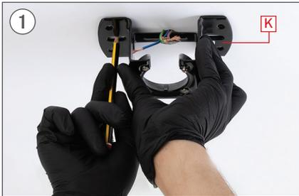
Markieren Sie mit einem Bleistift die 2 mittleren Löcher des Stücks **K** an der Decke mit dem gleichen Stück als Führung.
