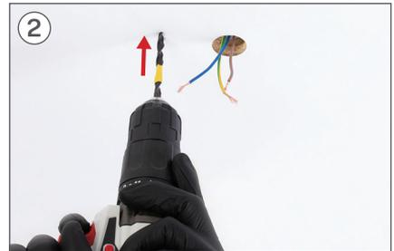
Gegebenenfalls müssen Sie je nach Art des Daches einen Bohrer verwenden, um das Loch in das Holz zu bohren.
