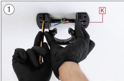
1 Markieren Sie die 2 zentralen Löcher des Stücks an der Decke mit einem Bleistift **K**. Verwenden Sie das gleiche Stück als Führung.
