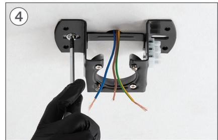
4 Das Stück platzieren **K** und schrauben Sie die Befestigungsschrauben an die Zwischendecke.
