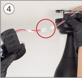
Verbinden Sie die Teilverbindungen B. mit den Anschlüssen von Motor, jeweils mit der entsprechenden Farbe.
