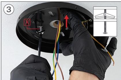
3 Führen Sie die Befestigungsschrauben in die Löcher ein und stellen Sie sicher, dass sich der Hebel öffnet.
