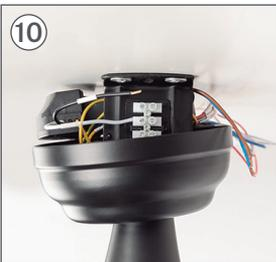
Verbinden Sie das L-Kabel des Treibers mit dem PHASE-Kabel Ihrer Installation.
