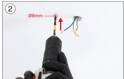
Mit Hilfe einer Bohrmaschine mit einem Bohrer Ø8 mm die beiden entsprechenden Löcher bohren.
