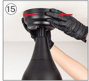
15 Drehen Sie das Teil nach dem Anbringen A nach links. Achten Sie darauf, dass keine Drähte eingeklemmt werden.
