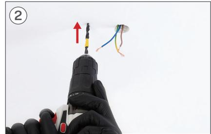
2 Mit Hilfe eines Bohrers die 2 entsprechenden Löcher bohren.
