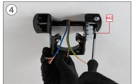
Ziehen Sie die Schrauben mit Hilfe des Schraubendrehers fest M2.
