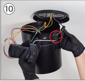
Schließen Sie das NEUTRAL-Kabel des Treibers (AC-N) an das NEUTRAL-Kabel Ihrer Installation an.
