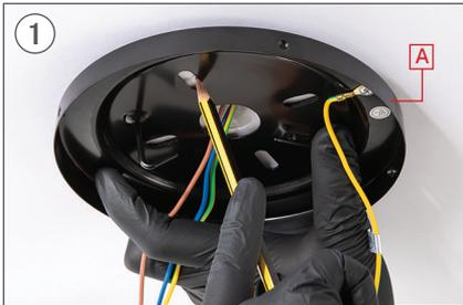
1 Markieren Sie mit einem Bleistift 2 parallele Löcher mit dem Stück A als Leitfaden.
