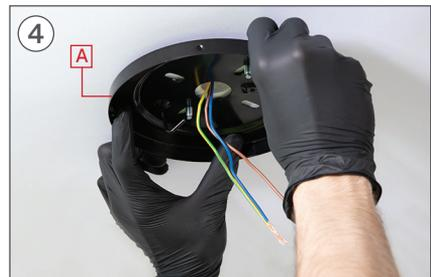
4 Platzieren Sie das Teil A. Passen Sie die Löcher an die Schrauben an D. Stellen Sie sicher, dass die Deckenkabel durch das mittlere Loch des Stücks verlaufen A.
