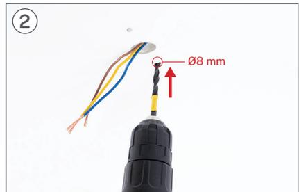
2 Bohren Sie mit einem Bohrer die beiden entsprechenden Löcher mit einem Bohrer mit  $\varnothing 8$  mm.
