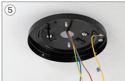
Stellen Sie sicher, dass das Teil A ist perfekt an der Decke befestigt.
