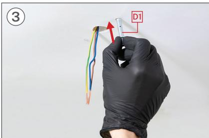
3 Setzen Sie die Teile ein D1 in den Löchern in der Decke.
