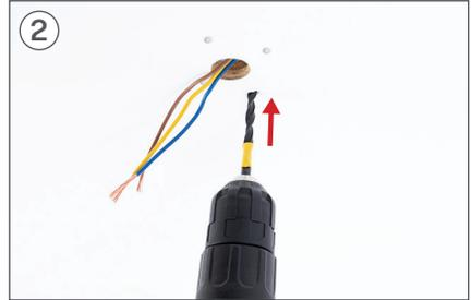
2 Falls erforderlich, müssen Sie je nach Dachart einen Bohrer verwenden, um das Loch in das Holz zu bohren.
