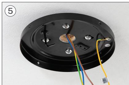
5 Stellen Sie sicher, dass das Teil A Es ist perfekt an der Decke befestigt, wobei die Schrauben gut angezogen sind.
