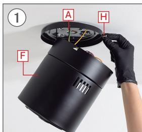
Verwenden Sie 2 Schrauben H und schrauben Sie sie locker in die parallelen Löcher im Teil A.
