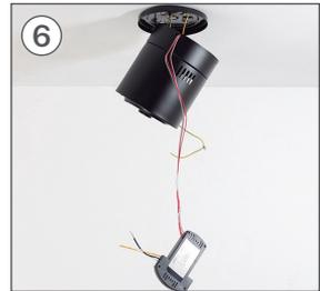
Verbinden Sie die Teilverbindungen F mit denen des Stückes B, jeweils mit der entsprechenden Farbe.
