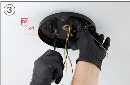
3 Platzieren Sie die Unterlegscheibe und dann die Schraube D2 mit Hilfe des Schraubendrehers.
