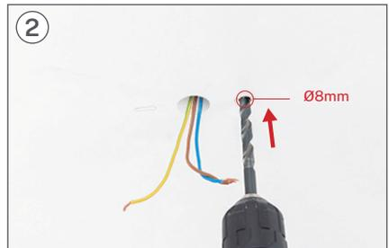
2 Bohren Sie mit Hilfe eines Bohrers die beiden entsprechenden Löcher mit einem Ø8-mm-Bohrer.
