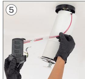
Verbinden Sie die Verbindungen des Stücks F mit denen des Stückes B, jeweils mit der entsprechenden Farbe.
