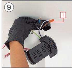
Verbinden Sie das NEUTRAL-Kabel des Treibers (AC-N) mit dem NEUTRAL-Kabel Ihrer Installation.
