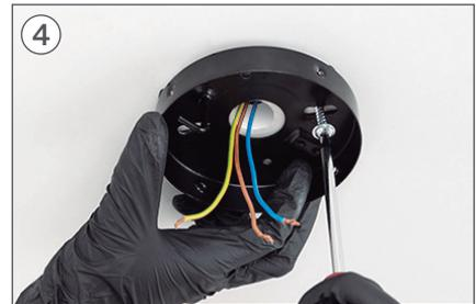
Das Stück platzieren A und schrauben Sie die Befestigungsschrauben an die Zwischendecke.
