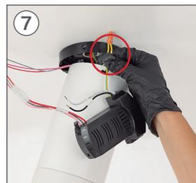
Wählen Sie alle Erdungskabel aus und schließen Sie sie an, einschließlich Ihrer Installation.
