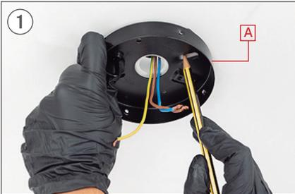
Markieren Sie an der Decke mit einem Bleistift 2 parallele Löcher mit dem Stück A als Leitfaden.
