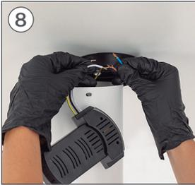
Verbinden Sie das PHASE-Kabel des Treibers (AC-L) mit dem PHASE-Kabel Ihrer Installation. Platzieren Sie das Teil nach dem Anschließen I.
