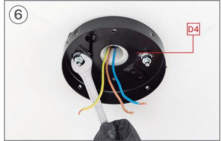
Das Teil festziehen D4 mit einem 10er Schraubenschlüssel, bis Sie merken, dass er gut befestigt ist.
