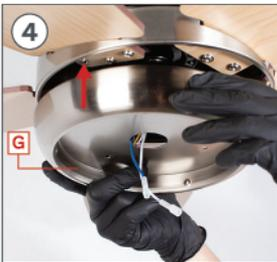
Platzieren Sie das Teil G Ausrichten der Löcher mit den Löchern im Motor.
