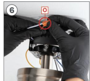
Verbinden Sie das PHASE (L) -Kabel Ihrer Installation mit dem weißen Kabel des Teils **B**.
