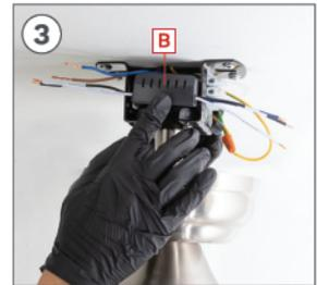
Fügen Sie das Teil ein **B** in der Teilnut **K**. Überprüfen Sie, ob alle Kabel korrekt verlegt sind, ohne sich zu verfangen.
