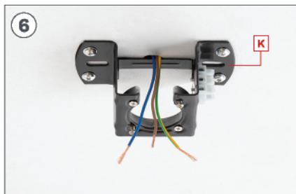
Stellen Sie sicher, dass das Teil **K** Es ist perfekt an der Decke befestigt und es sind keine Kabel eingeklemmt.
