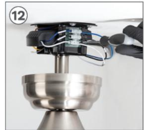
Verbinden Sie dann mit Hilfe eines flachen Schraubendrehers die verbleibenden Drähte des Teils **B** zu denen des Lüfters, die jeweils mit dem Streifen und seiner jeweiligen Farbe verbunden sind.
