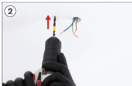
Machen Sie mit Hilfe eines Bohrers die 2 entsprechenden Löcher.
