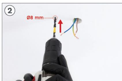
Bohren Sie mit Hilfe eines Bohrers die beiden entsprechenden Löcher mit einem Bohrer mit  $\varnothing 8$  mm.
