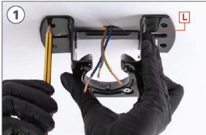
Markieren Sie mit einem Bleistift die 4 Löcher des Stücks an der Decke L.
