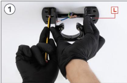
Markieren Sie an der Decke mit einem Bleistift die 2 zentralen Löcher des Stücks **L** unter Verwendung des gleichen Stücks als Leitfaden.
