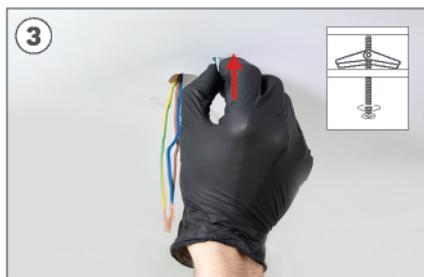
Setzen Sie die Befestigungsschrauben in die Löcher ein und stellen Sie sicher, dass sich der Hebel öffnet.
