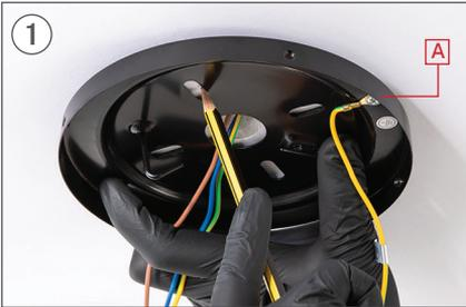
Markieren Sie mit einem Bleistift zwei parallele Löcher an der Decke, wobei Sie das Stück als Führung verwenden A.
