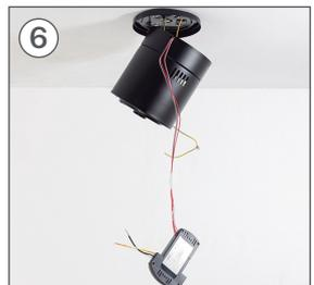
Verbinden Sie die Verbindungen des Stückes F mit denen des Stückes B, jedes mit seiner entsprechenden Farbe.
