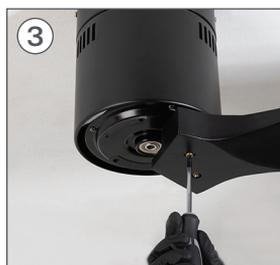
Platzieren Sie die erste Klinge E. Halten Sie es mit Unterlegscheiben und Schrauben fest G. Mit Hilfe des Schraubenziehers, ohne sie zu fest anzuziehen, um den Rest einsetzen zu können.
