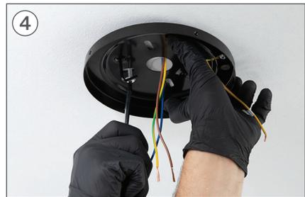
Platzieren Sie das Teil A und schrauben Sie die Befestigungsschrauben an die Zwischendecke.
