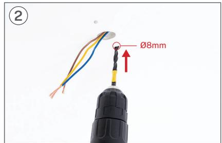
Bohren Sie mit Hilfe einer Bohrmaschine die beiden entsprechenden Löcher mit einem Ø8-mm-Bohrer.
