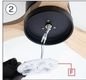
Verbinden Sie die Drähte des Teils F denen des Lüfters, der die Anschlüsse verbindet, jeweils in der gleichen Farbe.
