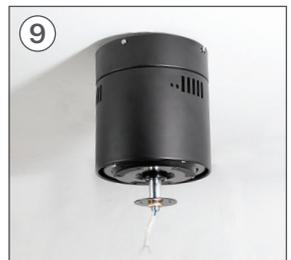
Sobald das Teil montiert ist **I**Setzen Sie die 2 Schrauben ein **K** in die verbleibenden Löcher, indem Sie sie mit dem Schraubendreher festziehen. Ziehen Sie dann die ersten 2 Schrauben fest, damit es sicher sitzt.
