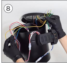
Wählen Sie alle Erdungskabel aus und schließen Sie sie an, einschließlich des Kabels für Ihre Installation.
