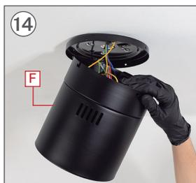
Sobald die Kabel angeschlossen sind, setzen Sie das Teil ein B im Inneren des Stückes F, Wie im Bild gezeigt.
