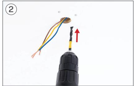
2 Gegebenenfalls müssen Sie je nach Dachtyp einen Bohrer verwenden, um das Loch in das Holz zu bohren.
