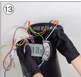
Verbinden Sie das NEUTRAL-Kabel des Treibers (AC-N) mit dem NEUTRAL-Kabel Ihrer Installation. Sobald die Verbindung hergestellt ist, platzieren Sie das Teil M
