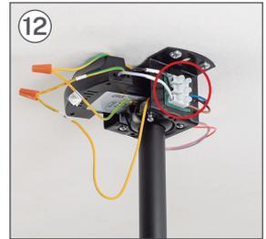
Stellen Sie sicher, dass keine eingeklemmten Drähte vorhanden sind.
