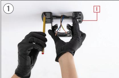
Markieren Sie an der Decke mit einem Bleistift die 2 zentralen Löcher des Stücks I mit dem Stück als Leitfaden.
