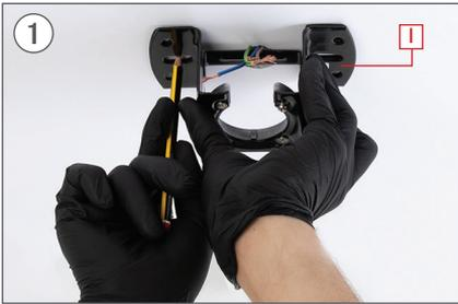
Markieren Sie an der Decke mit einem Bleistift die 2 zentralen Löcher des Stücks I unter Verwendung des gleichen Stücks als Leitfaden.
