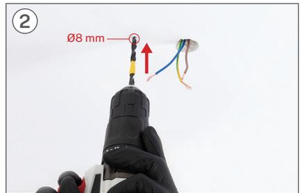
Bohren Sie mit Hilfe eines Bohrers die beiden entsprechenden Löcher mit einem Bohrer mit Ø8 mm.
