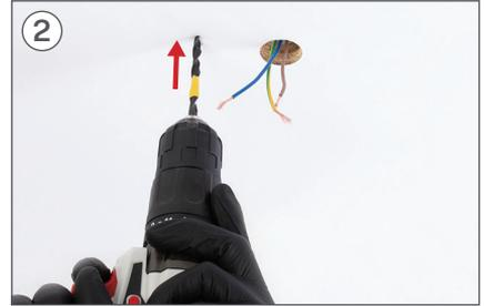
Bei Bedarf müssen Sie je nach Dachart einen Bohrer verwenden, um das Loch in das Holz zu bohren.
