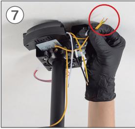
Wählen Sie die Erdungskabel aus und schließen Sie sie an, einschließlich des für Ihre Installation.
