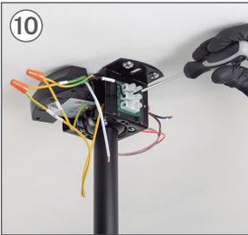
Verbinden Sie das LINE (L) Kabel des Treibers mit dem PHASE Kabel Ihrer Installation.
