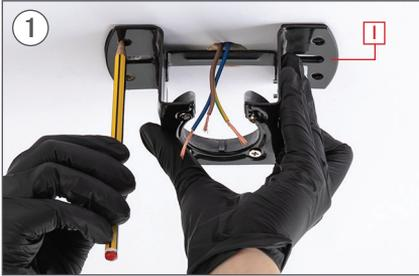
Markieren Sie mit einem Bleistift die 4 Löcher des Stücks an der Decke I.
