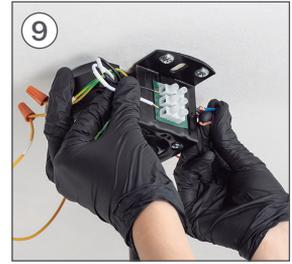
Sie müssen die verbleibenden Drähte im Teil bündeln B und die Phasen- und Neutralleiter seiner Installation im Klemmenblock des Stücks I, wie es im Folgenden gezeigt wird.
