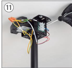
Verbinden Sie das NEUTRAL (N) Kabel des Treibers mit dem NEUTRAL-Kabel Ihrer Installation.
