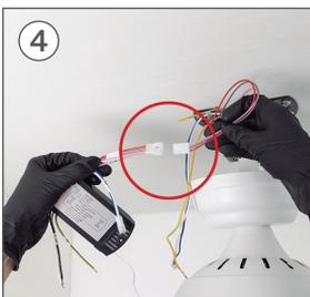
Verbinden Sie die Verbindungen des Stückes B. mit den Verbindungen der Motor, jeder mit seiner entsprechenden Farbe.
