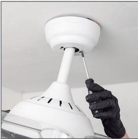
Ziehen Sie abschließend mit Hilfe eines Schraubendrehers die Schrauben auf der rechten Seite fest.
