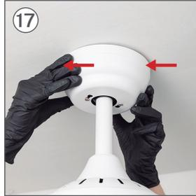
Nach dem Einbau drehen Sie das Teil A nach links. Achten Sie darauf, dass keine Drähte eingeklemmt werden.
