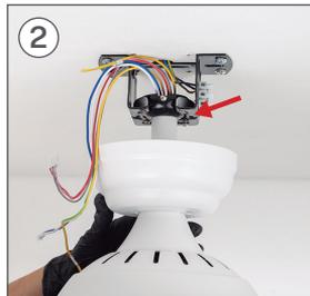
Denken Sie daran, die Kerbe an der Kipphalterung nach hinten zu positionieren, damit das Teil richtig passt.
