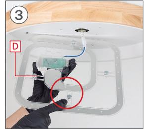
Verbinden Sie die Drähte des Teils D. zu denen des Ventilators, der die Anschlüsse verbindet.
