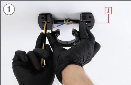
Markieren Sie mit einem Bleistift die beiden mittleren Löcher des Teils an der Decke J. Verwenden Sie das gleiche Stück als Orientierungshilfe.
