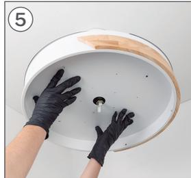
Lassen Sie die blauen und weißen Drähte durch das mittlere Loch der Verkleidung heraustreten
