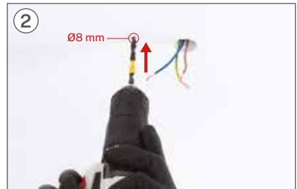
Bohren Sie mit Hilfe eines Bohrers die beiden entsprechenden Löcher mit einem Bohrer mit  $\varnothing 8 \text{ mm}$ .
