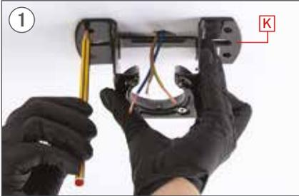
Markieren Sie mit einem Bleistift die 4 Löcher des Stückes an der Decke K.
