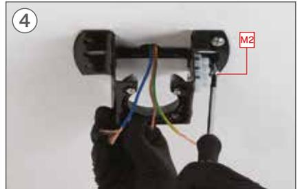
Ziehen Sie die Schraube mit dem Schraubendreher fest M2.
