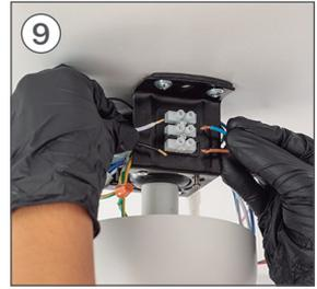
Sie müssen die restlichen Drähte aus dem Stück befestigen **B** und die Phasen- und Neutralkabel seiner Installation in der Leiste des Stücks **O**, wie im Folgenden gezeigt wird.
