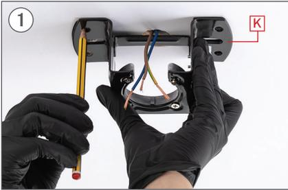
Markieren Sie mit einem Bleistift die 4 Löcher des Stücks an der Decke K.
