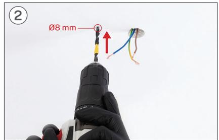
Bohren Sie mit Hilfe eines Bohrers die beiden entsprechenden Löcher mit einem Bohrer mit  $\text{Ø}8 \text{ mm}$ .
