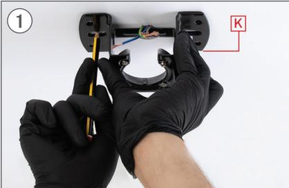
Markieren Sie an der Decke mit einem Bleistift die 2 zentralen Löcher des Stücks K mit dem Stück als Leitfaden.
