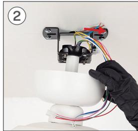
Denken Sie daran, die Kerbe an der Neigungshalterung nach hinten zu setzen, damit das Teil genau passt.
