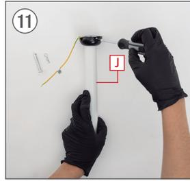
Ziehen Sie die beiden Schrauben an der Kipphalterung mit dem Schraubendreher fest.
