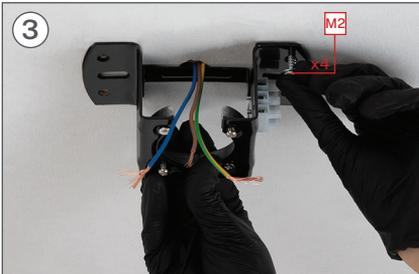
3 Platzieren Sie die Unterlegscheibe und dann die Schraube M2.
