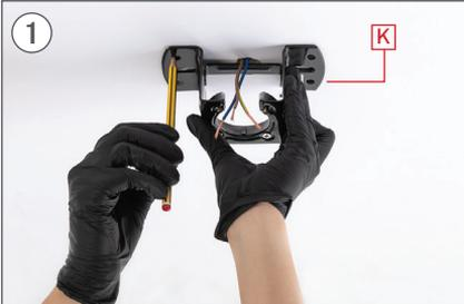
Markieren Sie an der Decke mit einem Bleistift die 2 zentralen Löcher des Stücks K mit dem Stück als Leitfaden.
