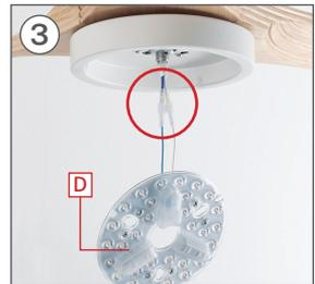
Teilekabel anschließen D zu denen des Lüfters, der die Verbindungen verbindet, jeder Draht mit der gleichen Farbe.
