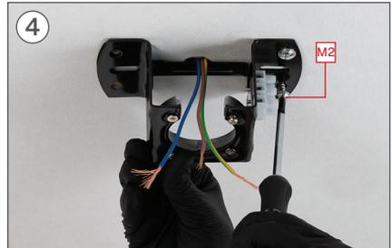
4 Ziehen Sie die Schraube mit dem Schraubendreher fest M2.
