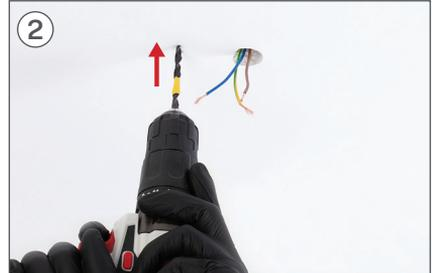
Machen Sie mit Hilfe eines Bohrers die beiden entsprechenden Löcher.
