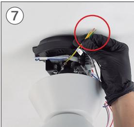
Wählen Sie alle Erdungskabel aus und schließen Sie sie an, einschließlich des für Ihre Installation.
