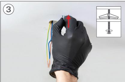
Setzen Sie die Befestigungsschrauben in die Löcher ein und stellen Sie sicher, dass sich der Hebel öffnet.
