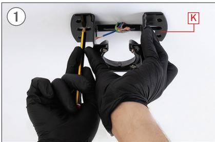
Markieren Sie an der Decke mit einem Bleistift die 2 zentralen Löcher des Stücks Kunter Verwendung des gleichen Stücks als Leitfaden.
