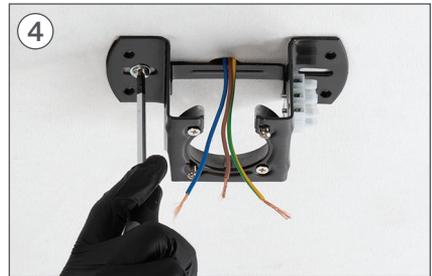
Platzieren Sie das Teil K und schrauben Sie die Befestigungsschrauben an die Zwischendecke.
