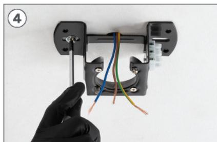
Platzieren Sie das Teil **K** und schrauben Sie die Befestigungsschrauben an die Zwischendecke.
