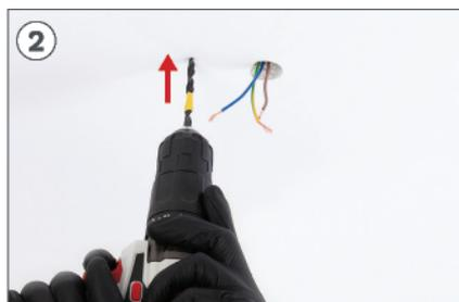
Machen Sie mit Hilfe eines Bohrers die beiden entsprechenden Löcher.
