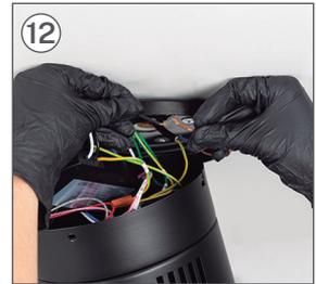
Verbinden Sie das PHASE-Kabel des Treibers (AC-L) mit dem PHASE-Kabel Ihrer Installation.
