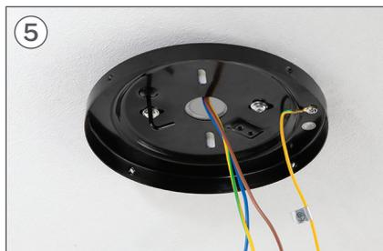
Stellen Sie sicher, dass das Teil **H** ist perfekt an der Decke befestigt.
