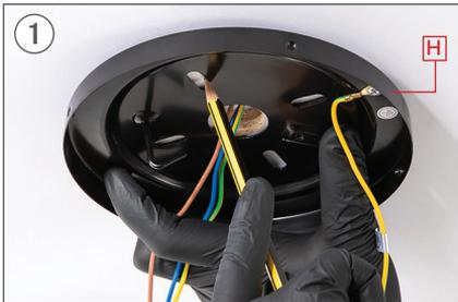
Markieren Sie mit einem Bleistift an der Decke die 4 Löcher des Stücks H.
