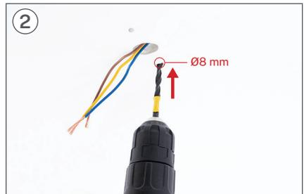
2 Bohren Sie mit einem Bohrer die beiden entsprechenden Löcher mit einem Bohrer mit Ø8 mm.
