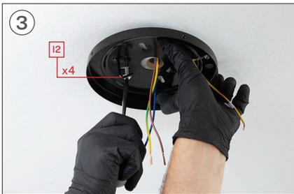
Platzieren Sie die Unterlegscheibe und dann die Schraube I2 mit Hilfe des Schraubendrehers.
