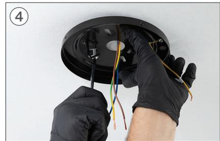
Platzieren Sie das Teil **H** und schrauben Sie die Befestigungsschrauben an die Zwischendecke.
