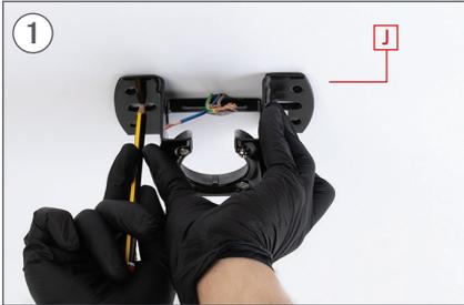
Markieren Sie die 2 zentralen Löcher an der Decke mit einem Bleistift, wobei Sie das Stück als Leitfaden verwenden J.
