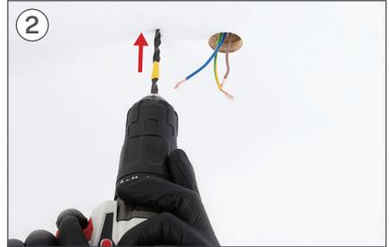
Falls erforderlich, müssen Sie je nach Dachart einen Bohrer verwenden, um das Loch in das Holz zu bohren.
