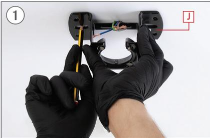
Markieren Sie mit einem Bleistift die 2 zentralen Löcher des Stücks J an der Decke mit dem gleichen Stück als Leitfaden.
