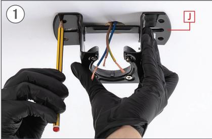
Markieren Sie mit einem Bleistift die 4 Löcher des Stücks J auf dem Dach.
