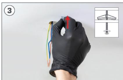
3 Setzen Sie die Befestigungsschrauben in die Löcher ein und stellen Sie sicher, dass sich der Hebel öffnet.
