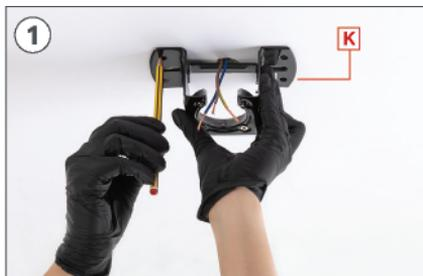
1 Markieren Sie an der Decke mit einem Bleistift die 2 zentralen Löcher des Stücks **K** mit dem Stück als Leitfaden.
