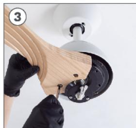
Wenn der Motor gut positioniert ist, beginnen wir mit der Montage der Flügel **E**.
