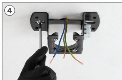
4 Platzieren Sie das Teil **K** und schrauben Sie die Befestigungsschrauben an die Zwischendecke.
