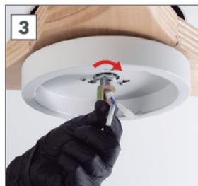
Führen Sie die Lüfterkabel vorsichtig in das Teil ein **S** und nehmen Sie sie heraus durch das große seitliche Loch des Stückes. Dann schrauben Sie das Teil **S**. und überprüfe das Überreste sicher am Lüfter befestigt.
