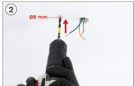
2 Bohren Sie mit Hilfe eines Bohrers die beiden entsprechenden Löcher mit einem Bohrer mit  $\varnothing 8$  mm.
