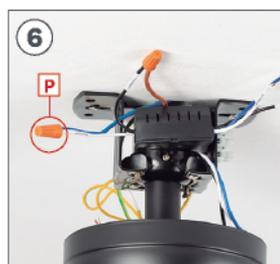
Verbinden Sie das PHASE (L)-Kabel Ihrer Installation mit dem PHASE-Kabel des Teils **B**. Sobald die Verbindung hergestellt ist, platzieren Sie das Teil **P** schrauben Sie es ein, bis es gut befestigt ist.
