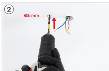
Mit Hilfe eines Bohrers die beiden entsprechenden Löcher mit einem  $\text{Ø}8 \text{ mm}$  Bohrer herstellen.
